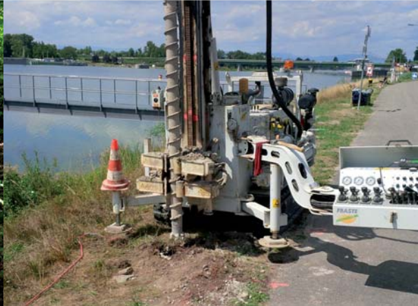
Kampfmittelsondierung im Tiefenbereich des Rheinseitendamms
