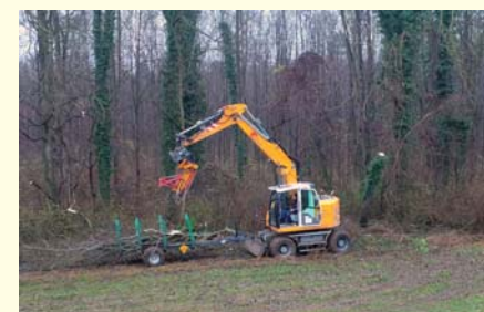
Rodungsarbeiten am Flügeldamm
